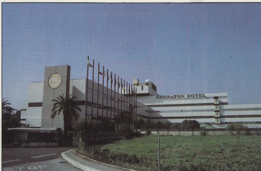
L'ingresso dell'Hotel Sheraton nella zona EUR di Roma
